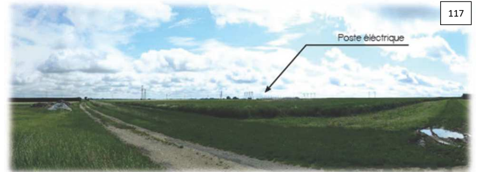
Figure 209 : Depuis la RD 164 en entrée de bourg d'Arconville, les vues en direction de la ZIP sont ouvertes sur le milieu agricole avec le poste électrique en second plan (Source : Étude paysagère de l'Agence Couâsnon)
