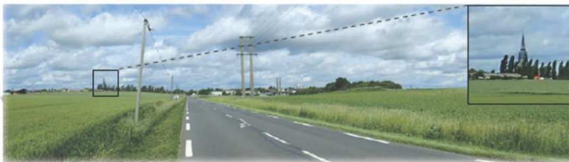
Figure 237 : Concurrence visuelle directe avec la silhouette de bourg de Beaune-la-Rolande (Source : Étude paysagère de l'Agence Coûasnon)
